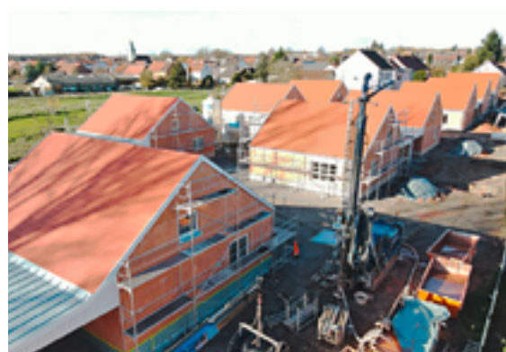
◀ Abb. 3: Erdwärmesonden-Bohrung im Baugebiet Hütschenhausen
