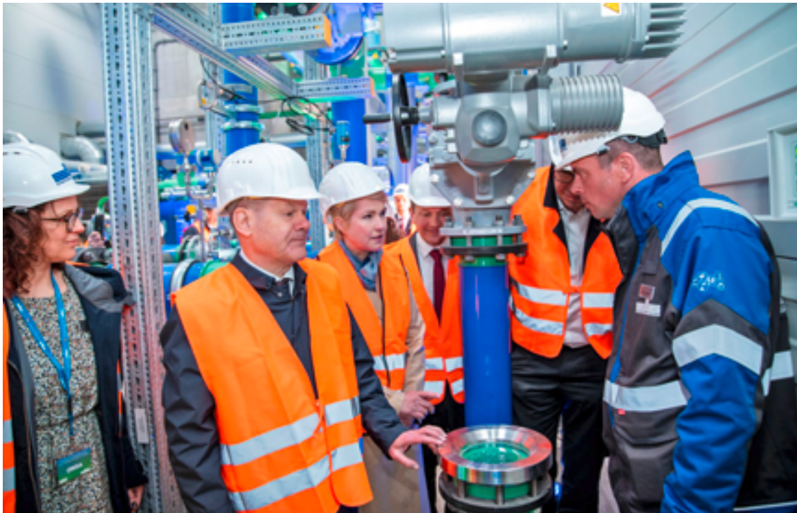
◀◀ Abb. 2: Künftig wird diese Anlage 15 Prozent des Schweriner Fernwärmebedarfs decken.
