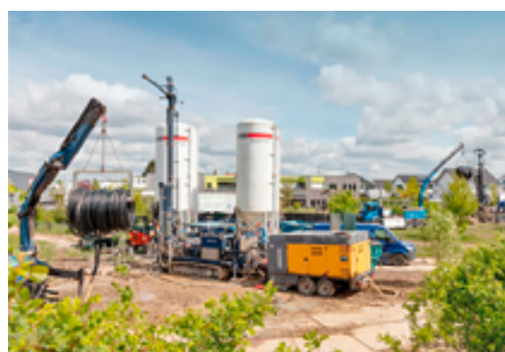
◀ Abb. 2: Erdwärmesonden-Bohrung im Baugebiet »Am Mauerle«
